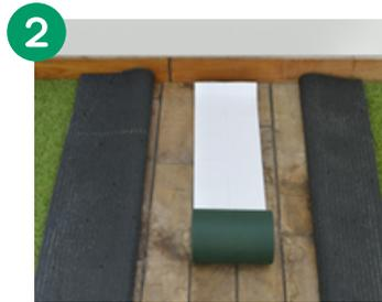
Positionner les lés de gazon bien bord à bord (pas de chevauchement!). Retourner les deux lés vers l'extérieur et placer la bande au milieu (film de protection vers le haut). Rabattre les lés de gazon et vérifier une dernière fois que les raccords soient bien calées bord à bord. Tirer ensuite la bande vers le haut et plaquer les lés en exerçant une pression.
