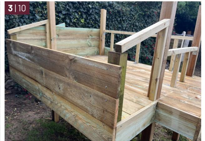
Ensuite, utilisez les poteaux de 1,45 m pour relier les 4 poteaux ensemble, les positionnant juste au-dessus des tasseaux déjà fixés. Ces poteaux doivent également déborder de 45 cm pour la plateforme d'entrée et le pondoir.
