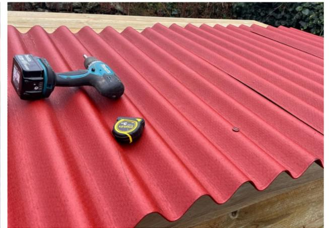
Placez une vis tous les 20 cm environ pour garantir une bonne stabilité et solidité. Laissez les plaques dépasser d'environ 7 cm de chaque côté du toit, offrant ainsi une protection supplémentaire contre la pluie et favorisant l'écoulement de l'eau. Ce chevauchement complémentaire des plaques assurera que le poulailler reste sec et confortable pour vos poules, même lors de fortes pluies.
