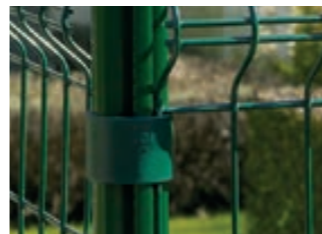
Poteau avec système de fixation à colliers
